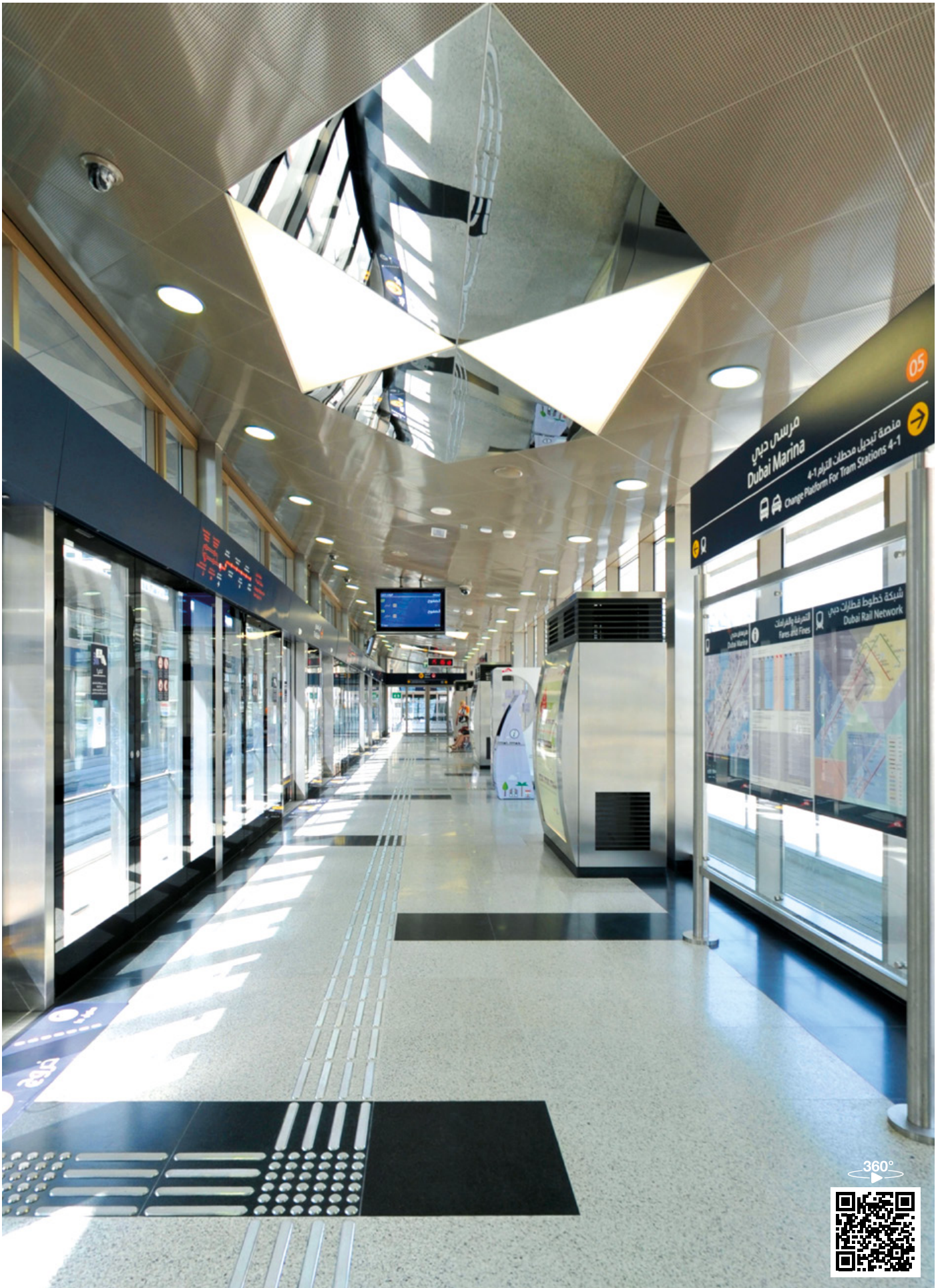
Design : SYSTRA from France Combinaison de toile miroir et de toile translucide lumineuse / Combination of mirror membrane and translucent luminous membrane / Kombination aus Spiegel Spannfolie und, lichtdurchlässigem Spannfolie
